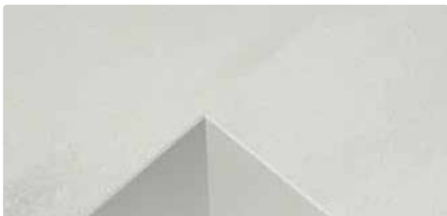
Raccord d'angle sans joint pour Corian Attention : malgré le collage sans joint, le décor n'est pas continu.
