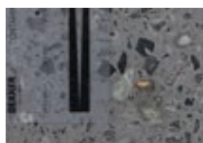
Oppervlakteverstoring: voelbare putjes en verstoringen in het oppervlak
